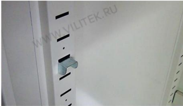
Рис. 4. Установка крепежных кронштейнов внутри шкафа.
